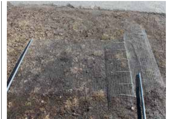
Nätet är uppmätt ca 2,30 m. Innerdelen t h i bild (ca 26–27 cm i diameter) har nästas fast med buntband.
